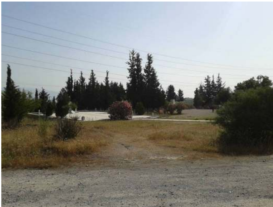
Εικόνα 44 – Το μνημείο των Θεσπιέων και ο περιβάλλοντας χώρος του με την υπάρχουσα ηθελημένη και αθέλητη βλάστηση που υπάρχει γύρω από αυτό. Στις εικόνες αυτές είναι εμφανής η οπτική όχληση που προκαλείται από τη γραμμή υψηλής τάσης που διέρχεται σε απόσταση περ. 100m από αυτό.
