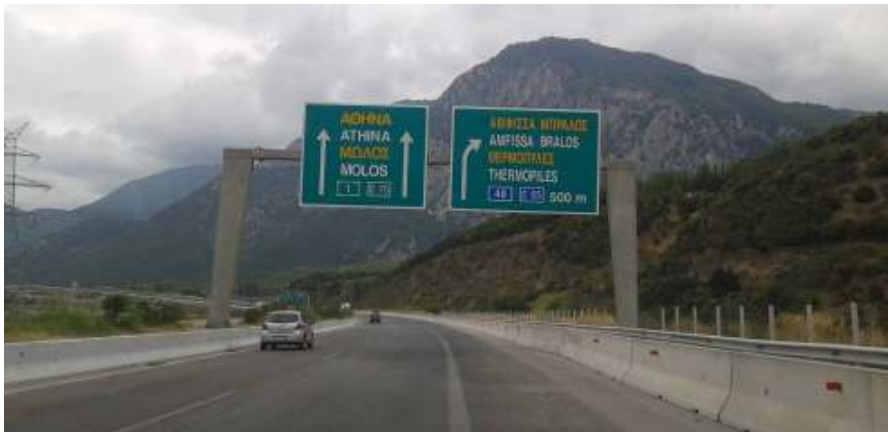
Εικόνα 28 – Η σήμανση της εξόδου προς Θερμοπύλες στον αυτοκινητόδρομο ΠΑΘΕ, από βορρά.
