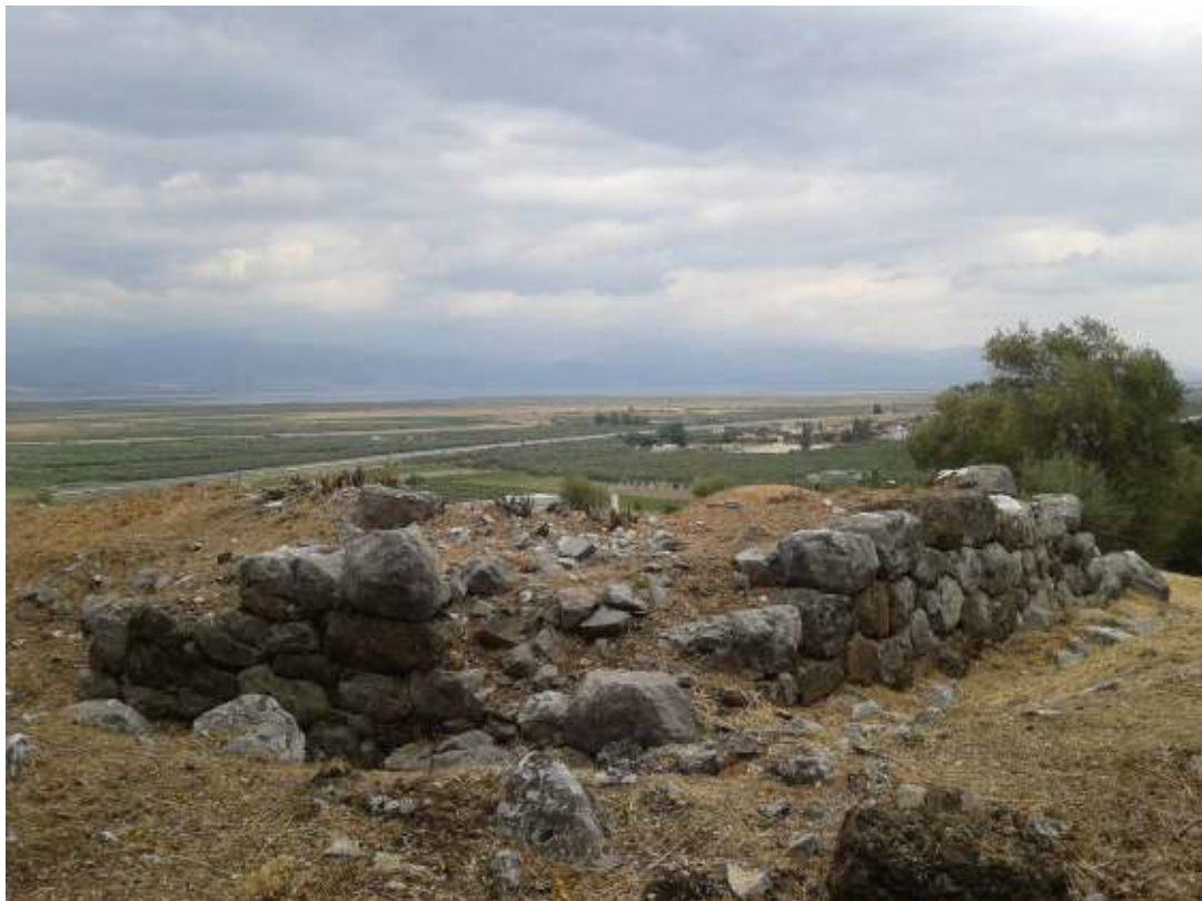
ΦΤ – Εικ. 21 – Το φυλάκειο που βρίσκεται στη νοτιοδυτική γωνία του Τείχους των Φωκέων
