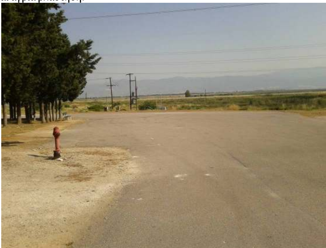
ΦΤ – Εικ. 10 – Ο ασφαλτοστρωμένος χώρος στάθμευσης δυτικά και βόρεια του αγάλματος του Λεωνίδα.
