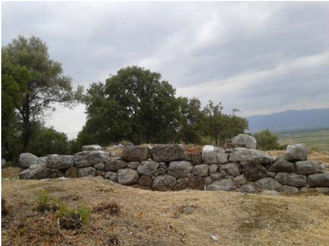
ΦΤ – Εικ. 19 – Το φυλάκειο που βρίσκεται στη νοτιοδυτική γωνία του Τείχους των Φωκέων
