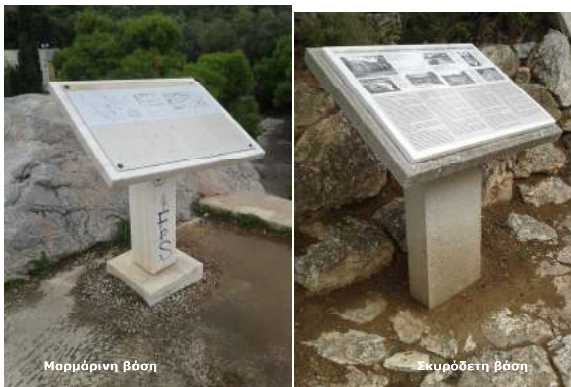
Εικόνα 100 – Δείγματα πινακίδων από επισμαλτωμένη λάβα και μαρμάρινη ή σκυρόδετη βάση, από αρχαιολογικούς χώρους στην Ελλάδα.
