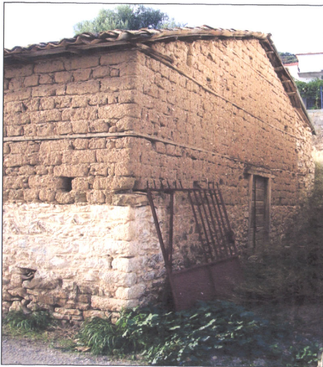
Εικόνα 3.3: Ανατολική όψη του κτιρίου.
