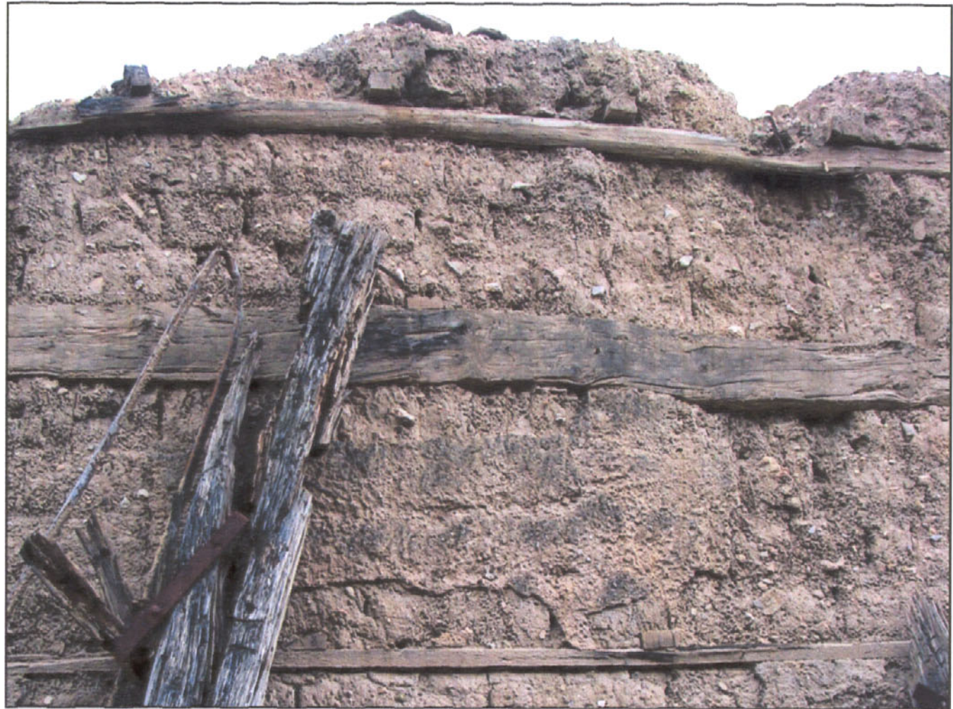
Εικόνα 3.1: Τοίχος ελαιοτριβείου από ωμόπλινθους(Καλογερικό ελαιοτριβείο Χρισσού). Πηγή: Αρχείο Π. Αραβαντινού
