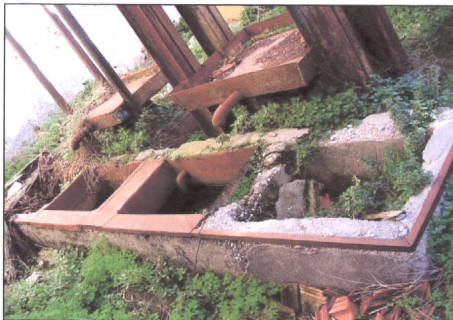
Εικόνα 1.22: Απορροή του πιεστηρίου από το ελαιοτριβείο των Σ. Τραχανά-Π. Αβραμίκου στην Άμφισσα. Πηγή: Αρχείο Π. Αραβαντινού.
