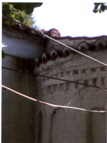
Φωτογραφία 27 : Εξωτερική βόρεια όψη του παρεκκλησίου
