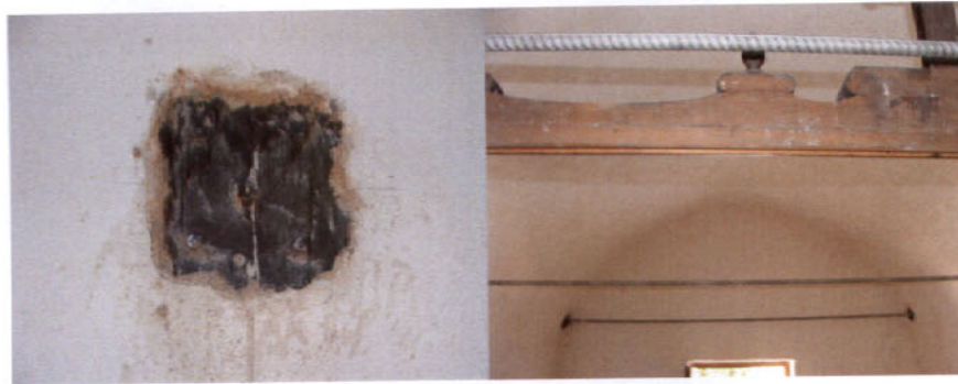
Προσθήκη ελκυστήρων σε εκκλησία του Αγίου Γεωργίου στους Θρακομακεδόνες
