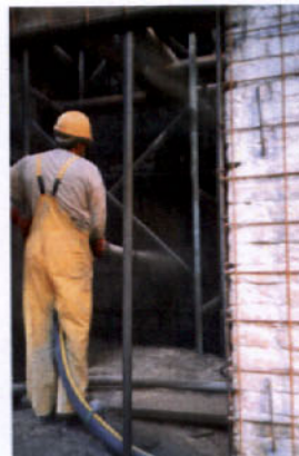
Εφαρμογή μεθόδου εκτοξευόμενου σκυροδέματος
