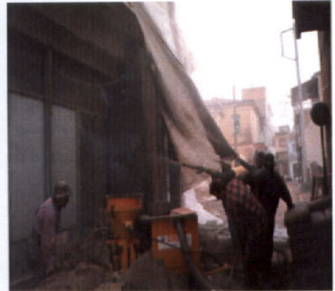
Εφαρμογή μεθόδου εκτοξευόμενου σκυροδέματος
