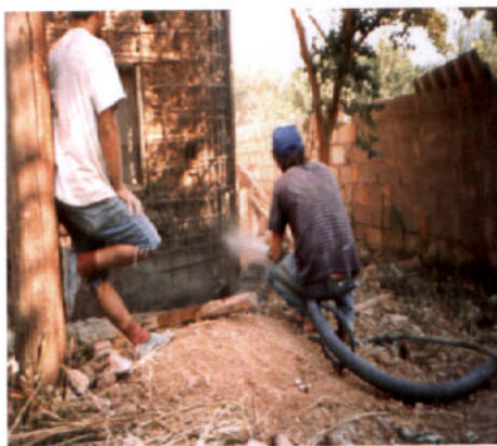
Εφαρμογή μεθόδου εκτοξευόμενου σκυροδέματος
