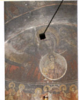
Φωτογραφία 2 : Ρωγμές μεταξύ της κόγχης και των παραβημάτων του Ιερού Βήματος
