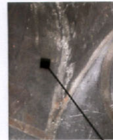
Φωτογραφία 2 : Ρωγμές μεταξύ της κόγχης και των παραβημάτων του Ιερού Βήματος
