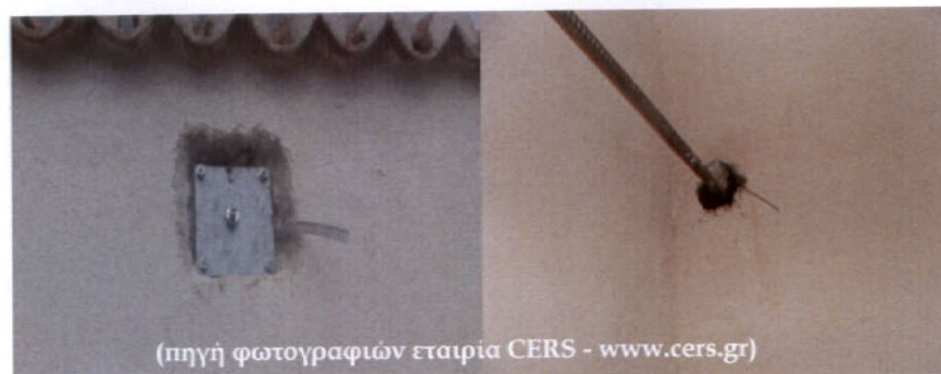
Προσθήκη ελκυστήρων σε εκκλησία του Αγίου Γεωργίου στους Θρακομακεδόνες
