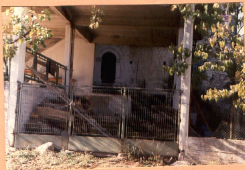
Νεοχώρι Τυμφρηστόν - Η νέα κατασκευή δια- φέρει το παλιό σπίτι με τα χαρακτηριστικά δια- φορές.
