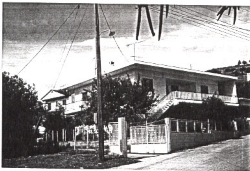
ΔΙΟΡΟΦΗ ΝΕΑ ΟΙΚΟΔΟΜΗ κ. ΛΥΜΠΕΡΗ πίσω από την Εκκλησία (Πλήρης αποστασιοποίηση από παραδοσιακές μορφές).
