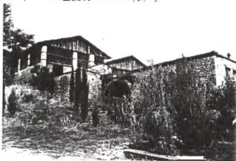
Το κτίσμα του ελαιοτριβείου και το κουτσέκι από νοτιοδυτικά
