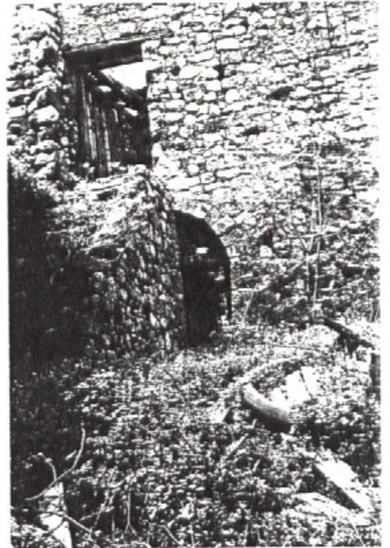
12. Η πυλή στην Ανατολική πλευρά όπως εμφανίζεται σήμερα φραγμένη από μεταγενέστερη σκαλιά
