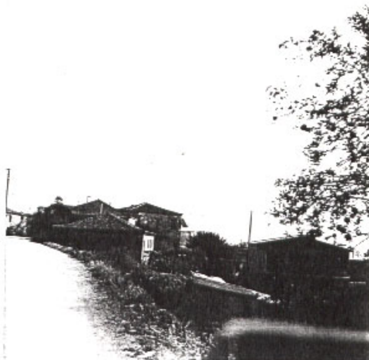
ΗΜΙΤΕΛΗΣ ΔΙΟΡΟΦΗ ΟΙΚΟΔΟΜΗ κ. ΜΗΤΣΟΥ (Παρατηρείται στέγη μη παραδοσιακής μορ- φής και συνεχής εξώση στην όψη).
