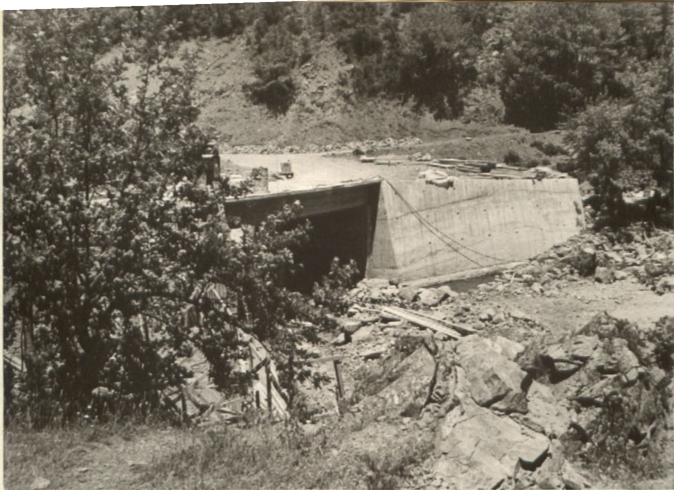
ΓΕΦΥΡΑ ΕΠΙ ΤΗΣ ΕΠΑΡΧΙΑΚΗΣ ΟΔΟΥ ΔΟΜΗΝΙΣΤΗΣ-ΣΤΑΛΛΟΝ-ΣΤΑΥΡΟΠΗΓΩΝ
