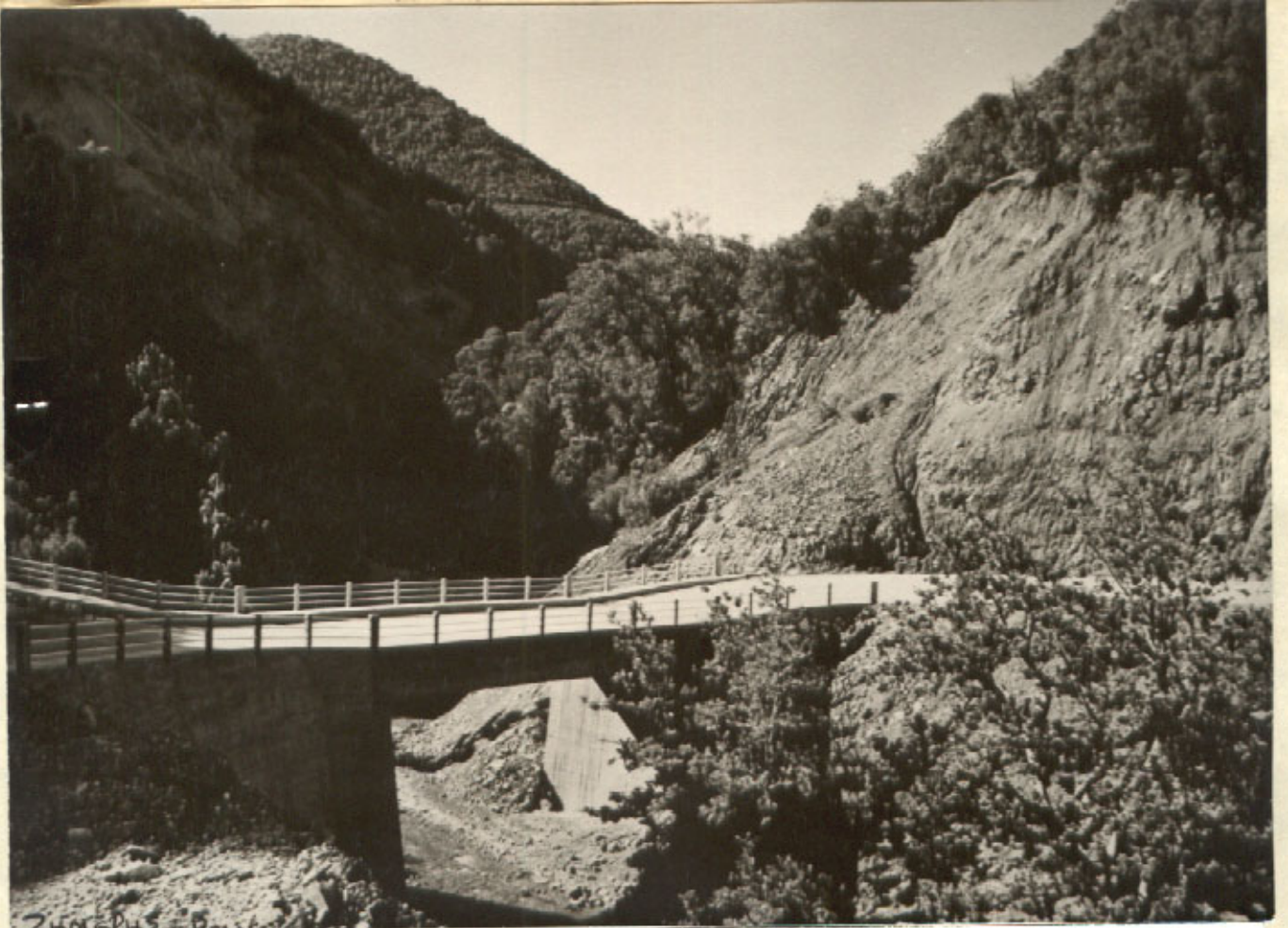
ΤΕΧΝΙΚΟΝ (ΓΕΦΥΡΑ) ΕΠΙ ΤΗΣ ΟΔΟΥ ΚΑΡΠΕΝΗΣΙΩΝ-ΑΓΡΙΝΙΩΝ
