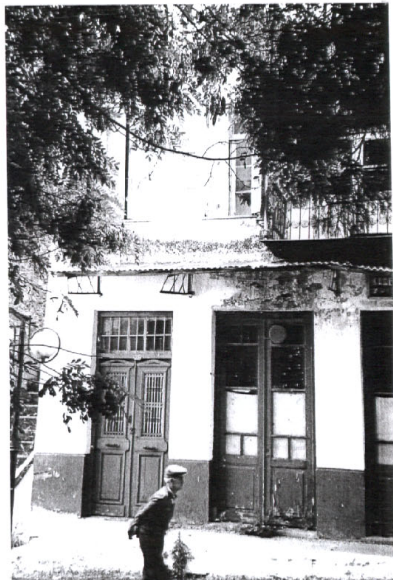
Το μεταλλικό στέγαστρο ισογείου αν και απλό και κακοδιατηρημένο στην περίπτωση του κτίσματος αυτού , ήταν βασικό μορφολογικό αλλά και λειτουργικό στοιχείο των αστικών οικημάτων , απόλυτα αναγκαίο λόγω κλιματολογικών συνθηκών
