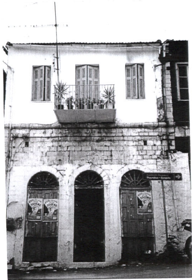
Ένα ακόμη διατηρημένο δείγμα αστικού οικήματος από τα παλαιότερα με ανυψωμένο ισόγειο κατάστημα και εντυπωσιακά κατεργασμένη ισόδομα πέτρα στην πρόσοψη
