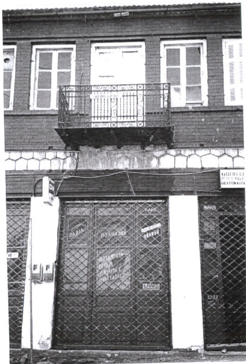
Οι διαφώτιστες επιφάνειες των καταστημάτων έδωσαν την ευκαιρία στους τοπικούς ξυλουργούς και σιδεράδες σε ορισμένες περιπτώσεις να εξαντλήσουν όλο τους το κατασκευαστικό ταλέντο και την εφευρετικότητα
