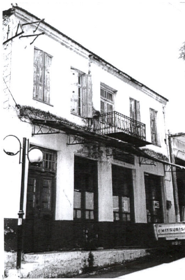
Ένα από τα αυθεντικότερα αστικά οικήματα που σώζεται μέχρι σήμερα σε κακή όμως κατάσταση
