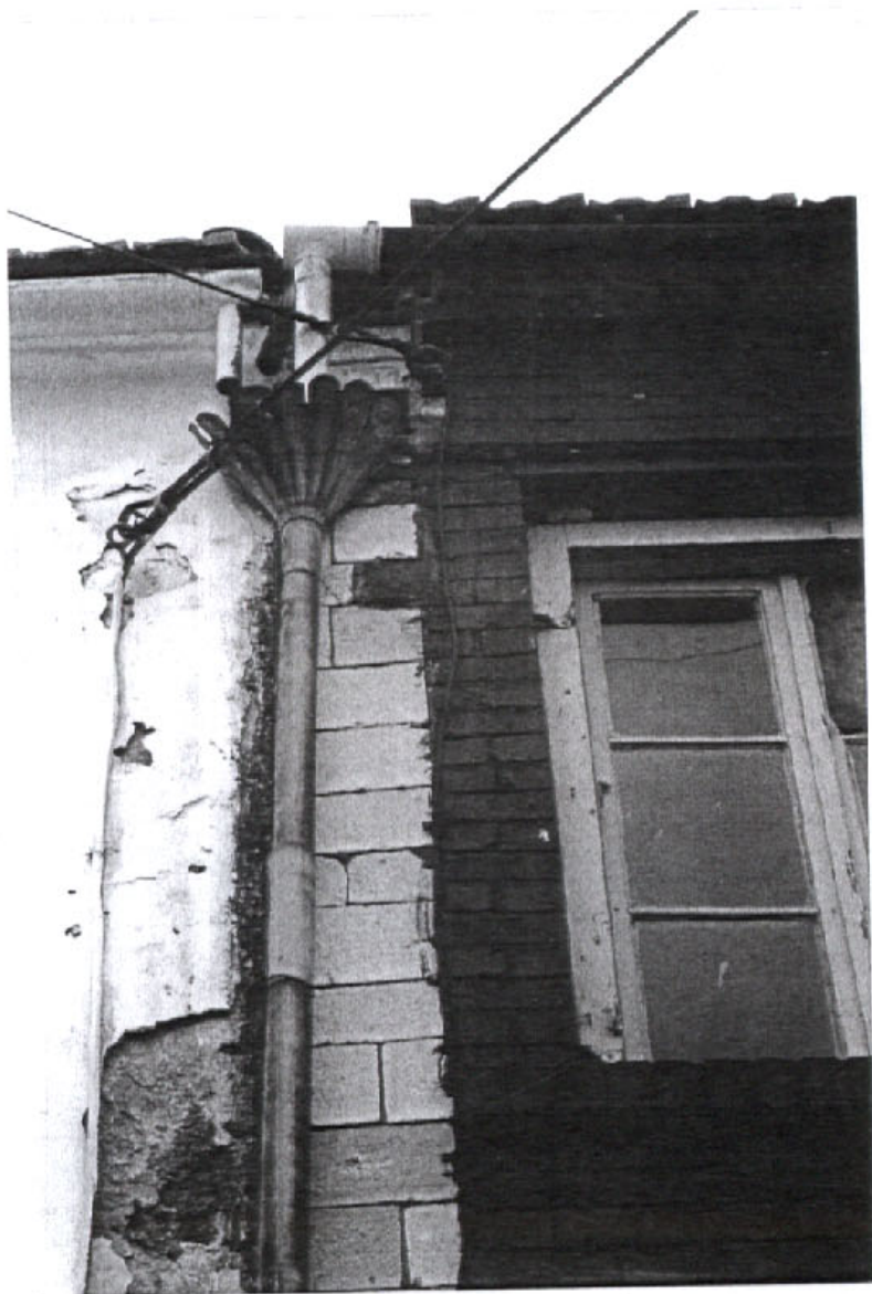
Μια παλαιά κεφαλή υδρορροής πραγματικό κόσμημα από το ... 1901 , όπως αναφέρει και η επιτοίχια πλακέτα πάνω από αυτήν
