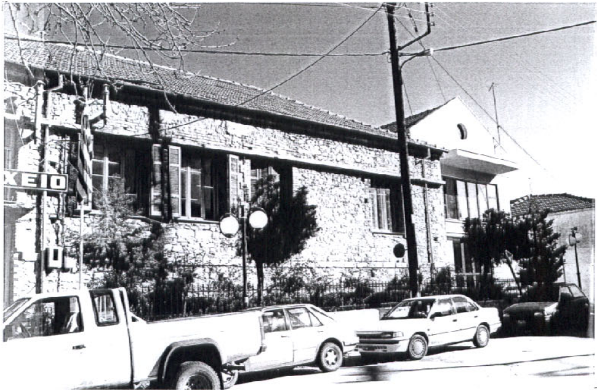
Το παλιό «Σχολείο», Δημαρχείο τώρα, έχει δεχθεί μέχρι σήμερα τρεις τουλάχιστον προσθήκες που ευτυχώς ελάχιστα επηρέασαν την βασική του νότια όψη
