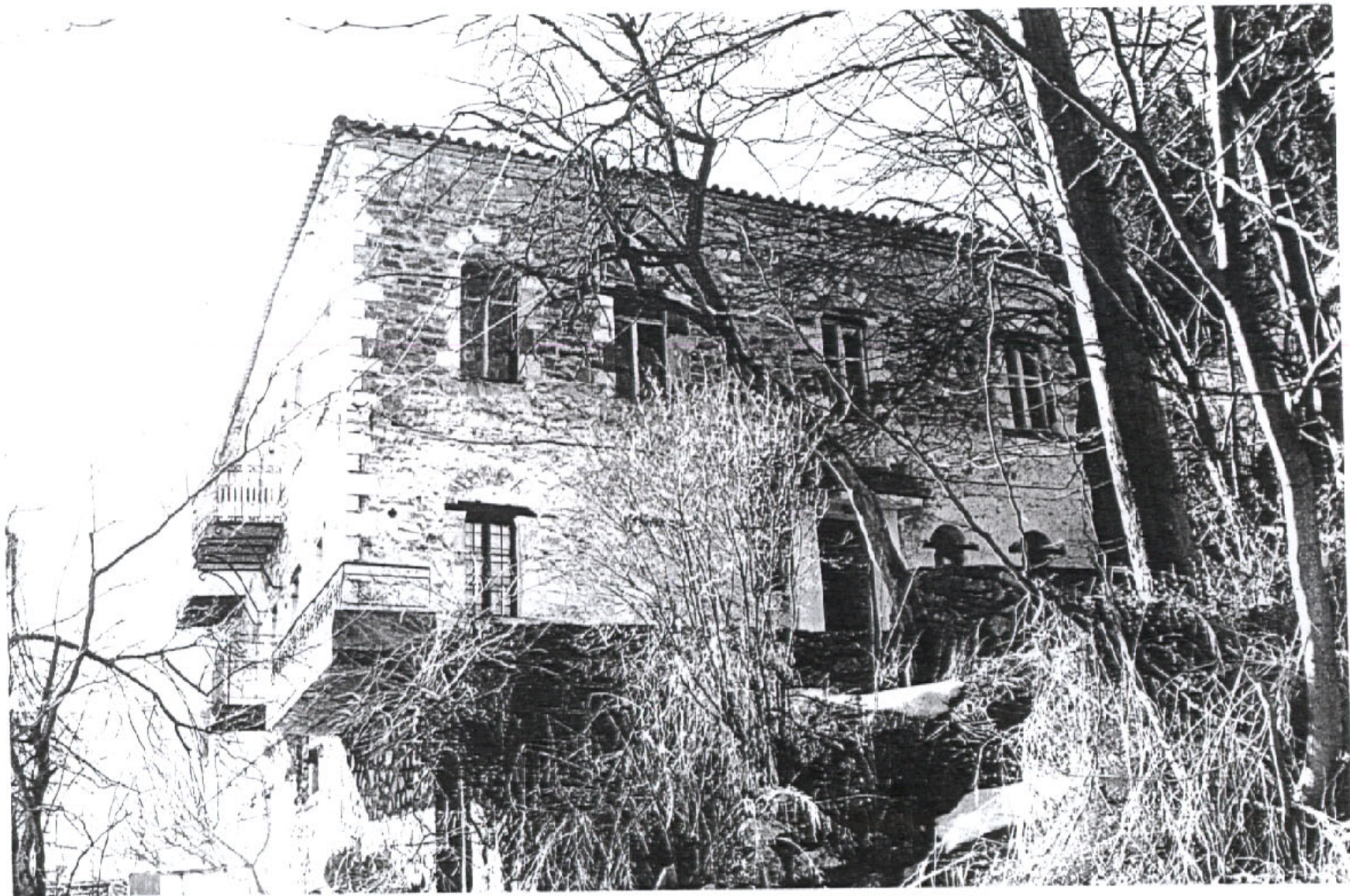
Αυτή η πιο «καθαρή» βόρεια όψη του κτίσματος υποδηλώνει τις παραδοσιακές αρχές της λιθοδομής του φ.ο. του , με σημεία αιχμής τους τα υπέρθυρα και τις γωνιολιθοδομές του , αλλά και τα περίτεχνα κιγκλιδώματα
