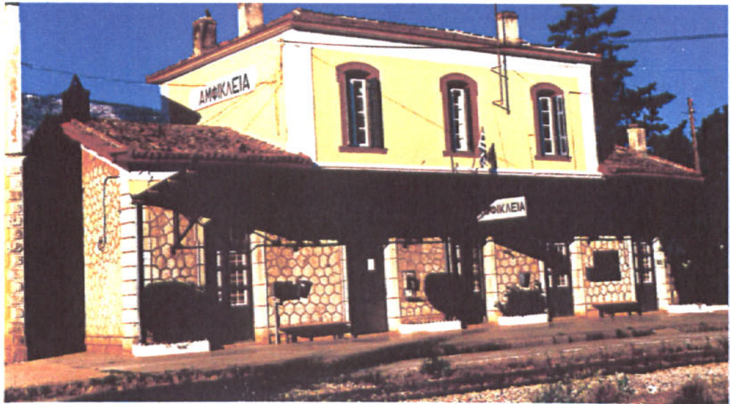
Φωτ.4 : Ο σταθμός της Αμφίκλειας (Δαδί) φιλοξενούσε προπολεμικά μηχανοστάσιο με ατμάμαξα εφεδρείας.
