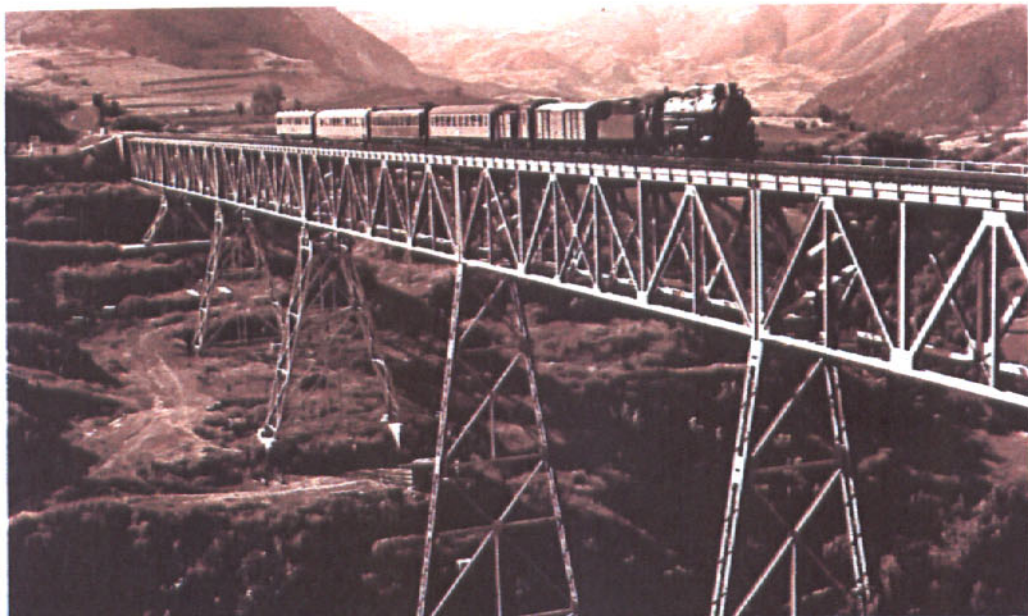
Φωτ.6 : Αποκατεστημένη η γέφυρα της Παπαδιάς (περιοχή Μπράλλου) στα πρώτα μεταπολεμικά χρόνια με το Simplon Orient Express.
