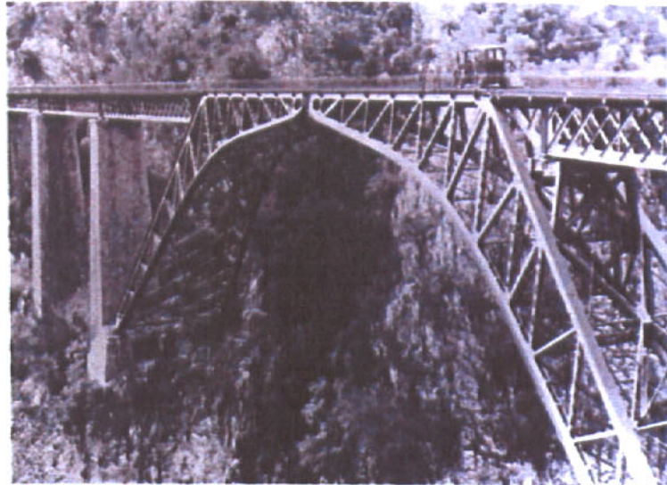
Φωτ.7 : Η παλιά γέφυρα του Ασωπού προπολεμικά. Ο κεντρικός φορέας της αποτελείται από τριαρθρωτό τόξο.
