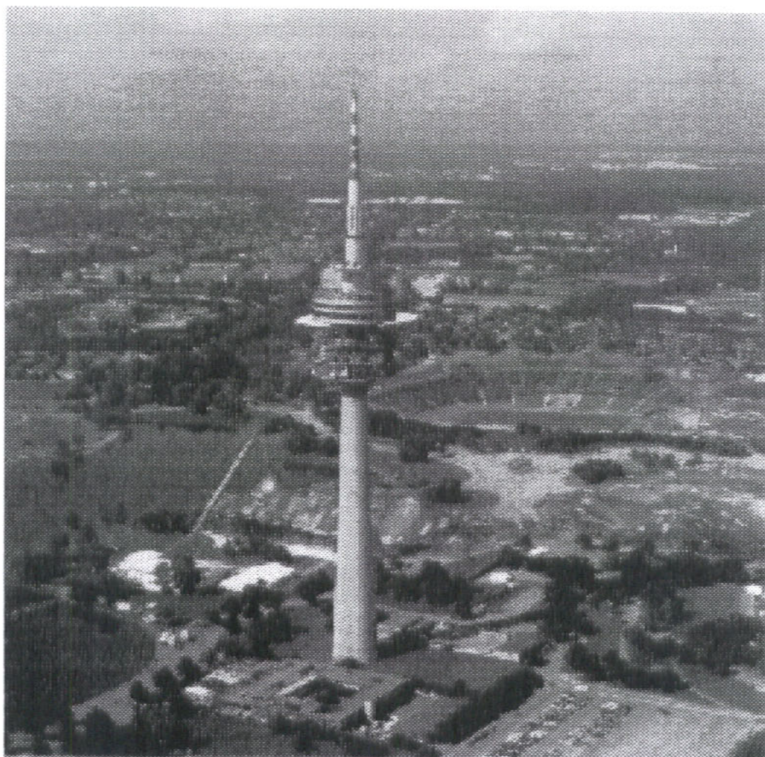
Σχήμα 7.7: Εγκατάσταση Olympic Tower Munich
