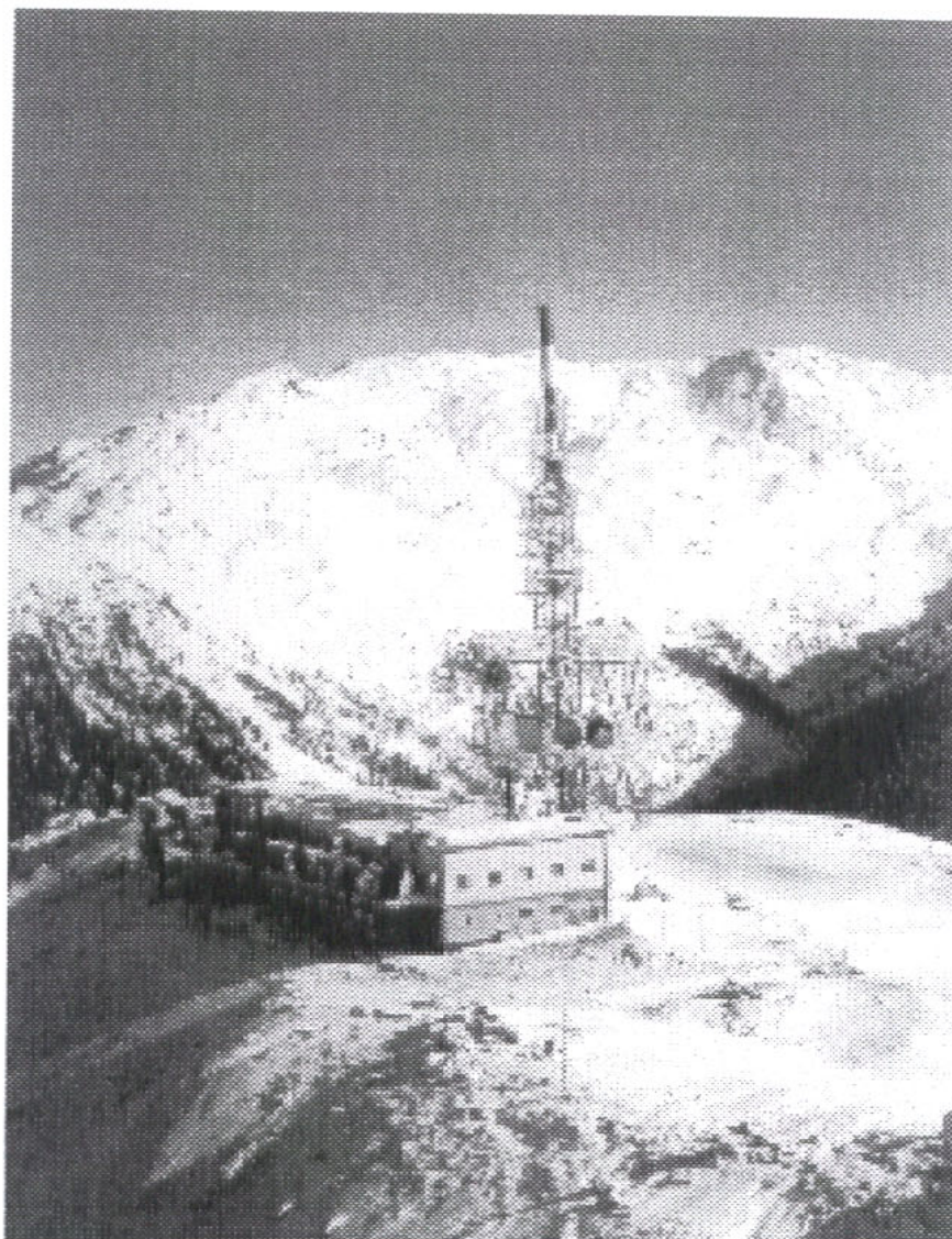
Σχήμα 7.19: Εγκατάσταση Patscherkofel, Innsbruck
