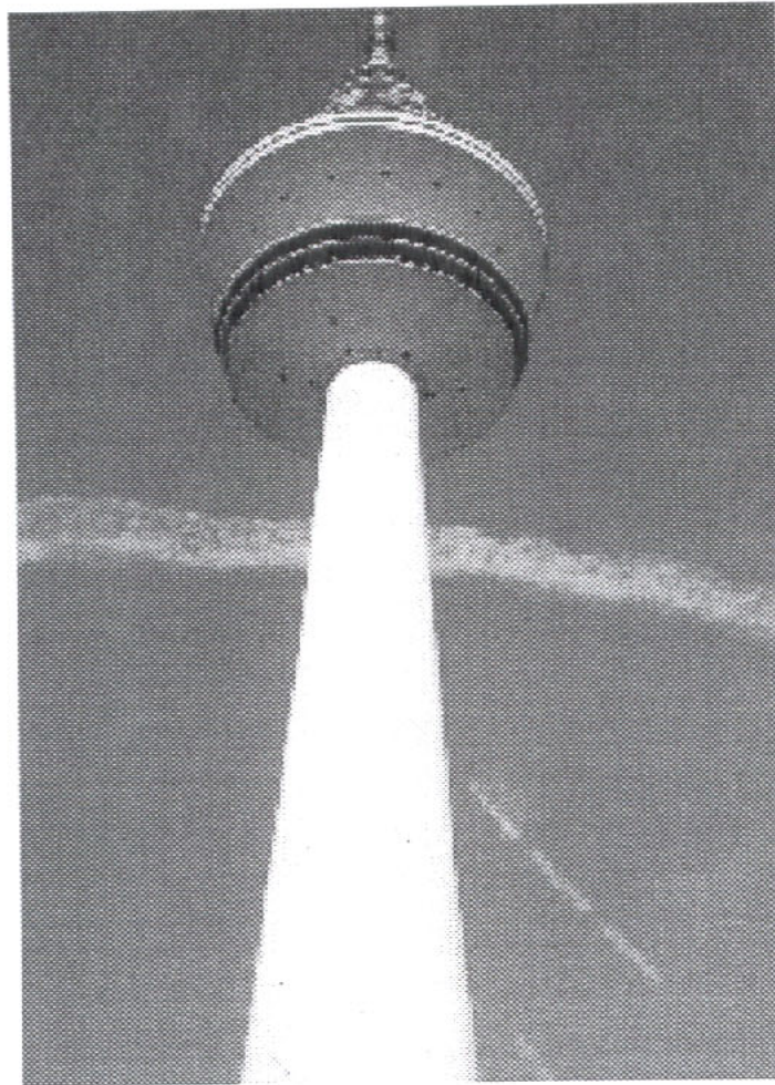
Σχήμα 7.14: Εγκατάσταση Deutsche Telekom
