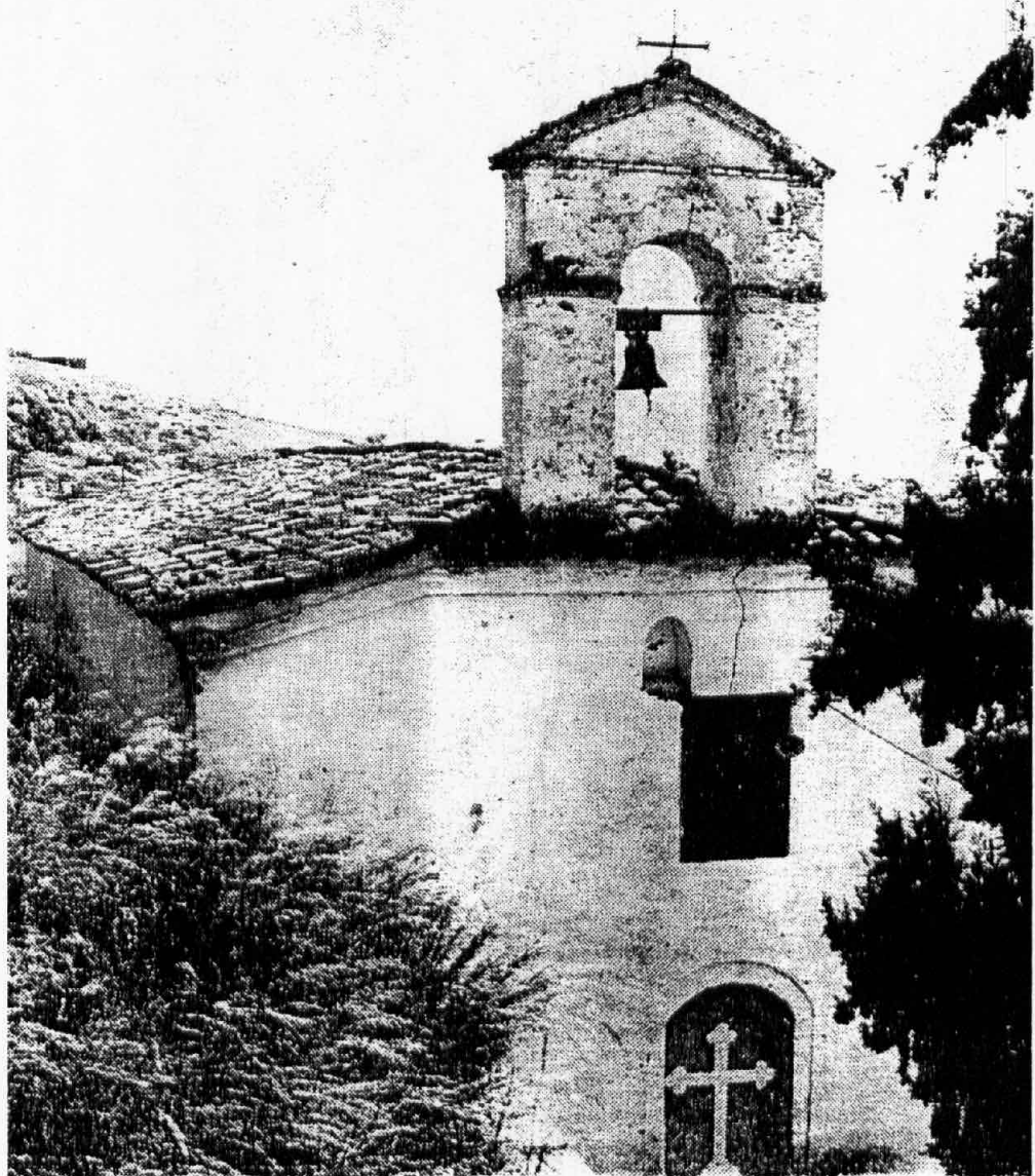
Εικ. 74. Η δυτική πλευρά του ναού πριν τις πρόσφατες επισκευές (από φωτογραφία του Ν. Δαβανελλού)
