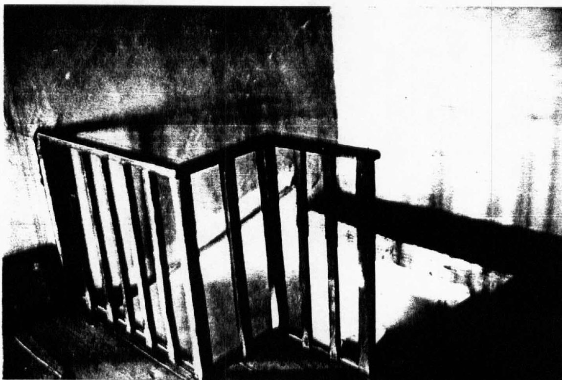
Εικ. 28. Τελείωμα σκάλας και ξύλινο δάπεδο γυναικωνίτη
