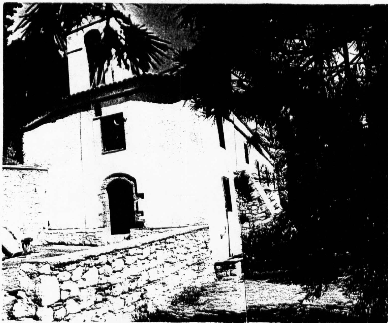
Εικ. 67. Δυτική και νότια όψη.
