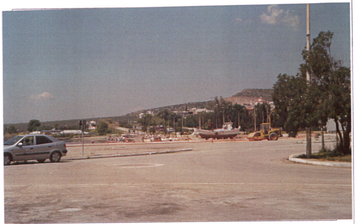
ΦΩΤ 8 ΤΟ ΝΑΥΠΗΓΕΙΟ ΜΕΓΚΡΩΝ ΣΚΑΦΩΝ ΣΤΟ ΛΙΜΑΝΙ
