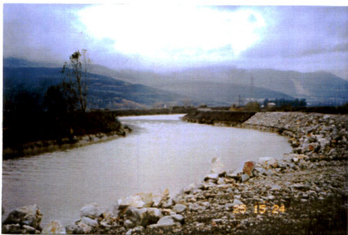
ΦΩΤ. 75—76 : Αντιπλημμυρικά έργα στο Σπερχειο κατάντι γεφυρας Αλαμανας
