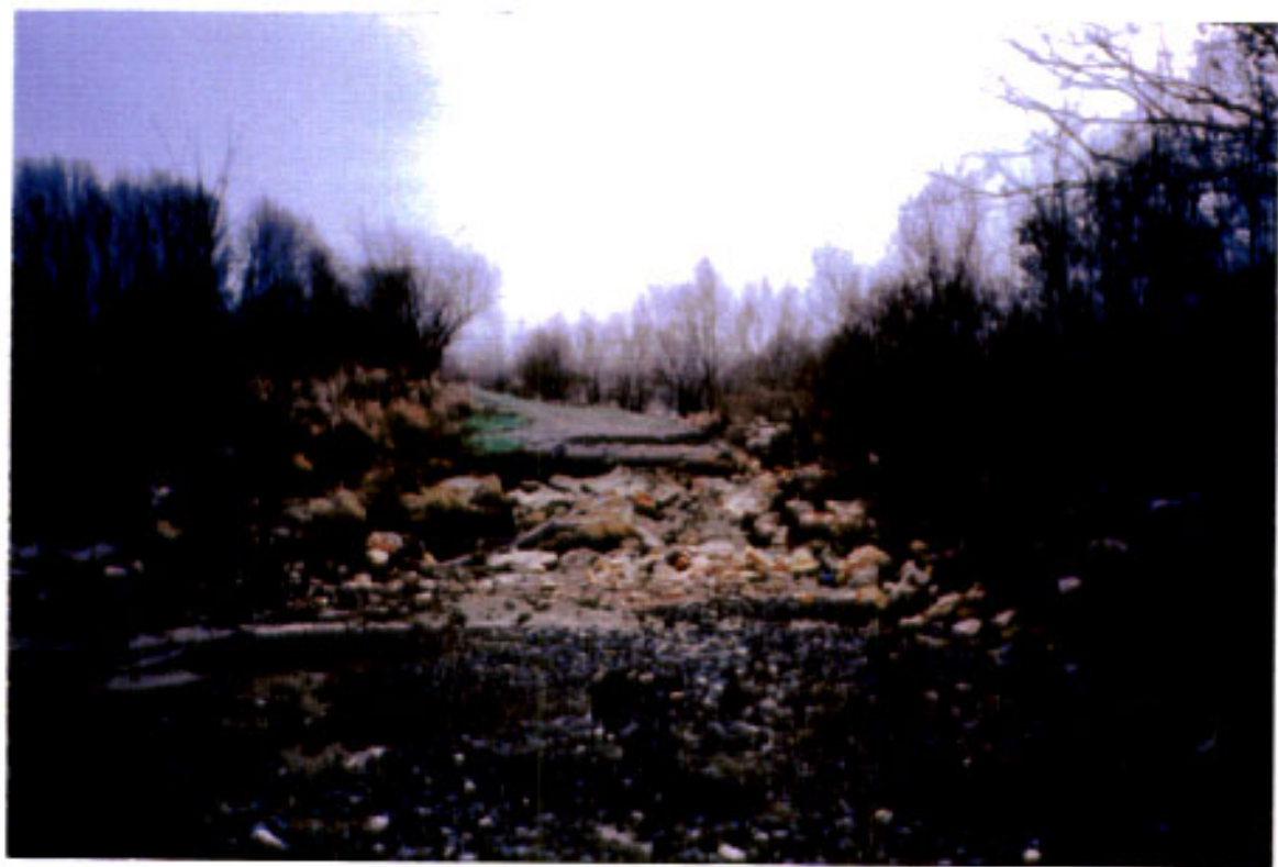
ΦΩΤ. 15 - 16 : Καταστροφές πλημμυρων στην κοιλάδα του Σπερχειού
