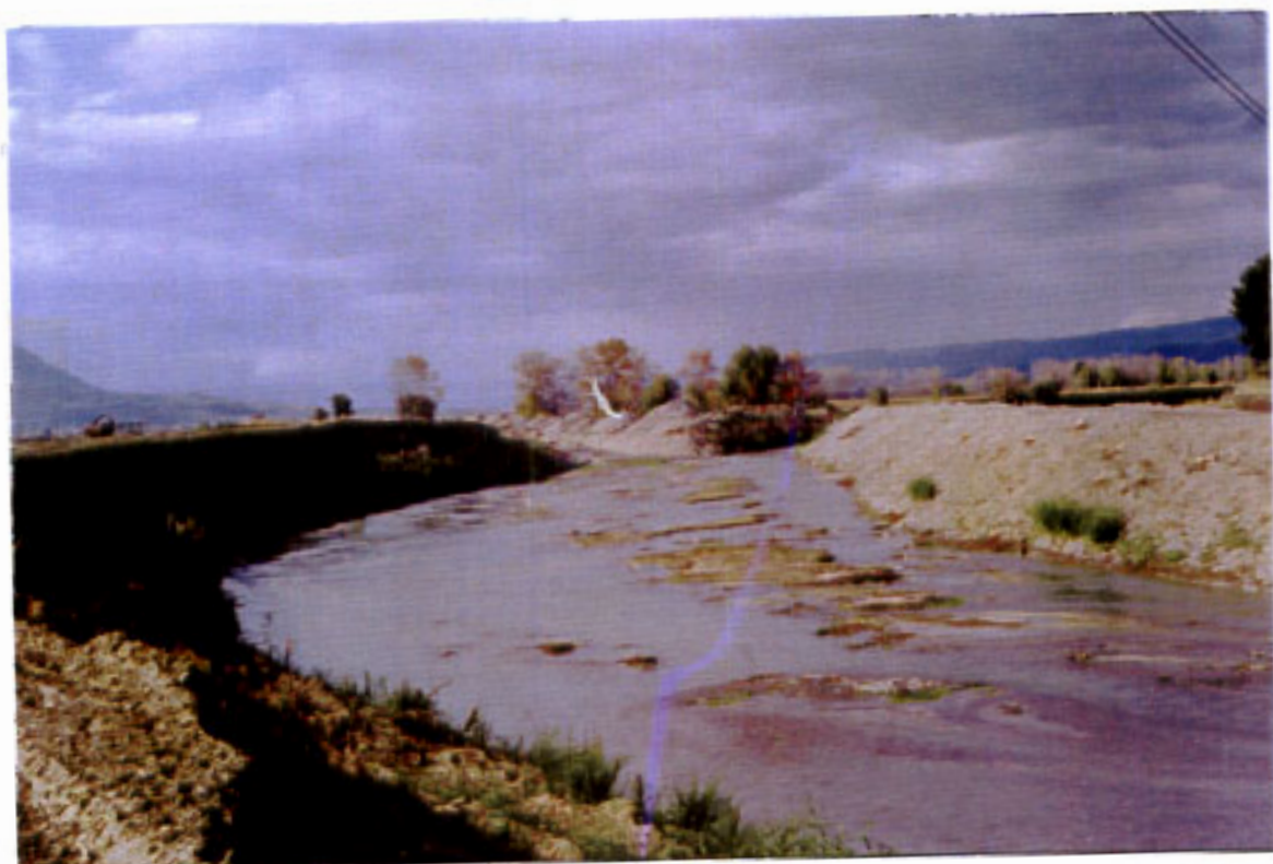
ΦΩΤ. 73-74 : Αντιπλημμυρικά έργα στο Σπερχειό αναντι γεφυρας Αλαμανας
