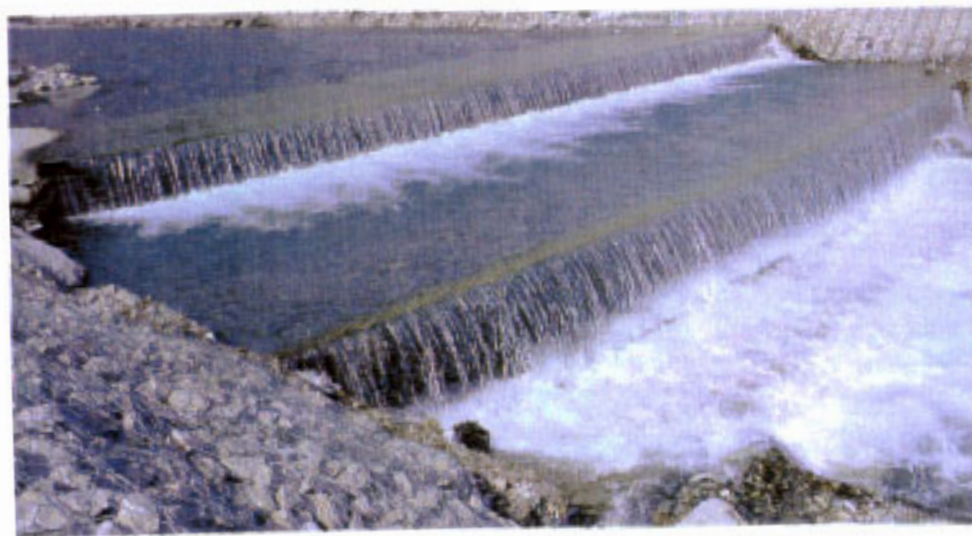
ΦΩΤ. 79 - 80 : Έργα προστασίας και αναβαθμών σε χειμαρρούς της λεκανής του Σπερχείου
