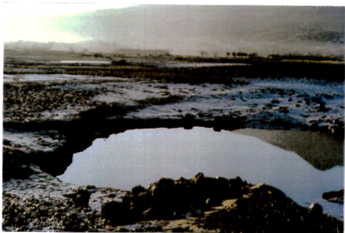
ΦΩΤ. 11-12 : Καταστροφές πλημμυρων στην κοιλάδα του Σπερχειού
