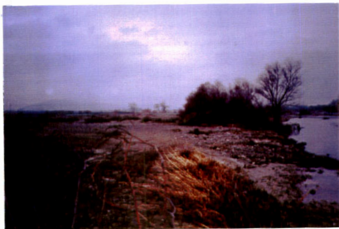
ΦΩΤ. 45—46 : Ελλειψη συντήρησης — αλλοίωση κοίτης φυσικών και τεχνητών αποδεκτών
