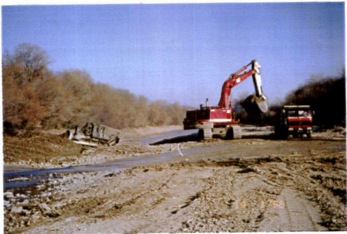
ΦΩΤ. 71-72 : Κατασκευή αναχωμάτων στον Σπέρχειο
