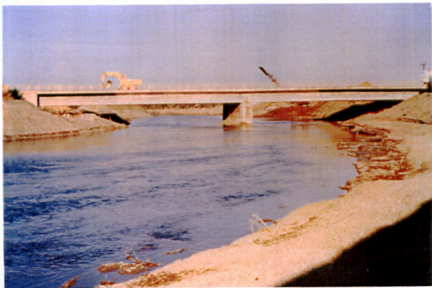
ΦΩΤ. 61—62 : Αντιπλημμυρικά έργα Σπερχείου στη γέφυρα Αλαμάνας
