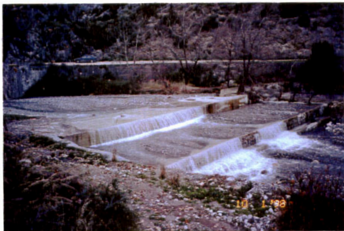
ΦΩΤ. 65-66 : Χειμαρρος Ασωπου — αναβαθμοί
