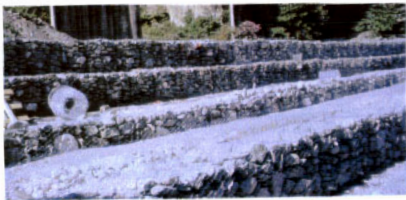
ΦΩΤ. 79 - 80 : Έργα προστασίας και αναβαθμών σε χειμαρρούς της λεκανής του Σπερχείου
