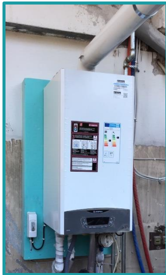
Παραδείγματα εσφαλμένης τοποθέτησης λεβήτων
