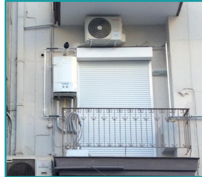
Τοποθέτηση λεβήτων σε μπαλκόνια
