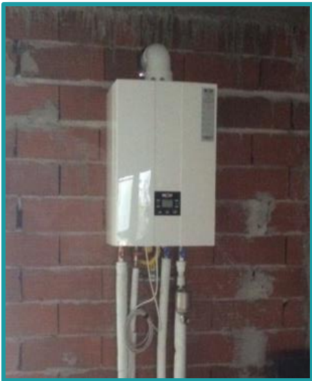
Παραδείγματα εσφαλμένης τοποθέτησης λεβήτων
