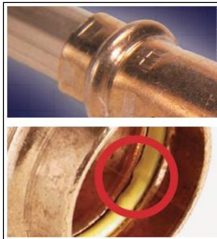
Σύνδεση με πρεσαριστά εξαρτήματα κατά DVGW G 5614
