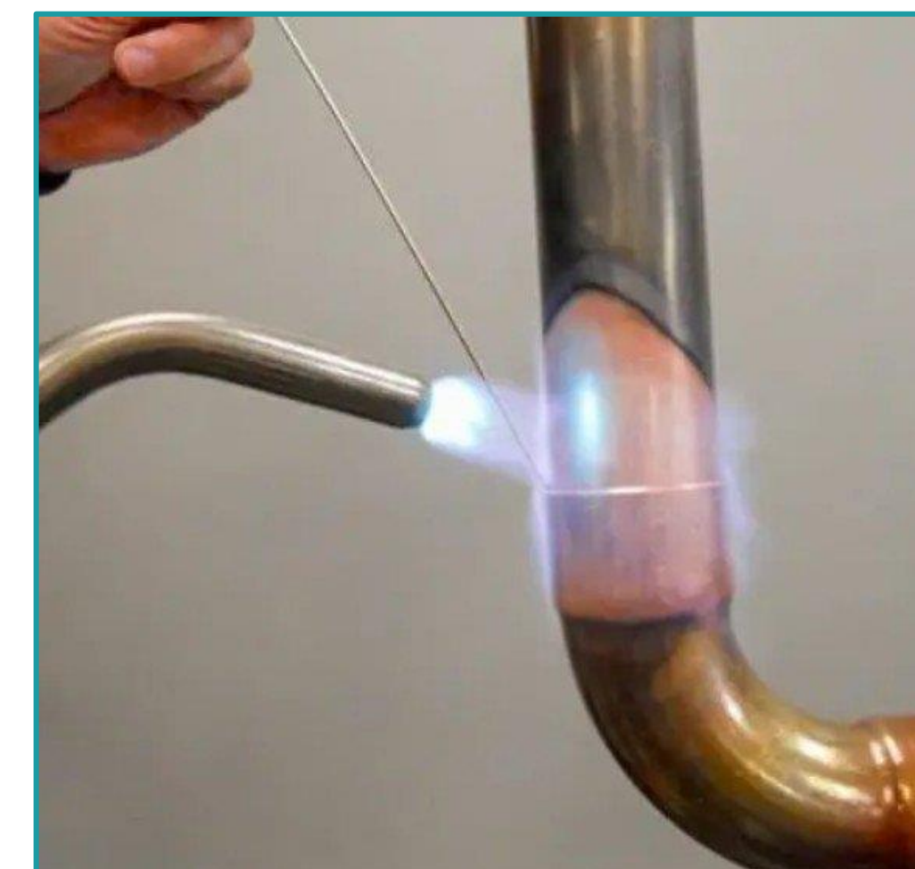
Σύνδεση με σκληρή κόλληση
