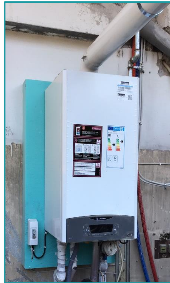
Παραδείγματα εσφαλμένης τοποθέτησης λεβήτων
