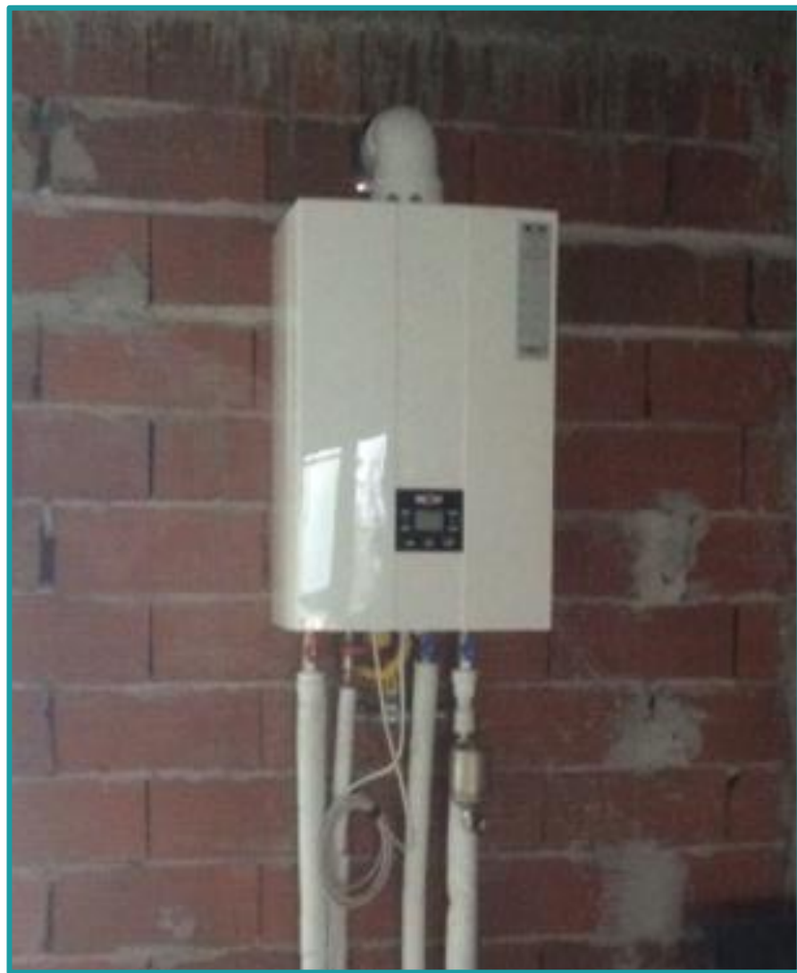
Παραδείγματα εσφαλμένης τοποθέτησης λεβήτων
